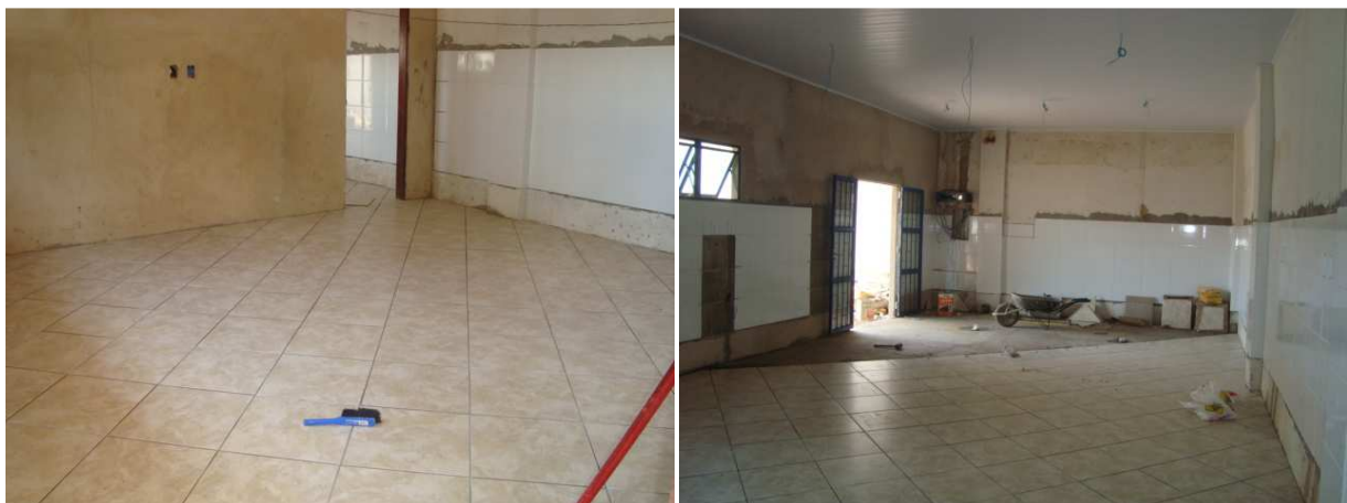
Figura 3.5. Construção do Novo Laboratório de Sedimentos
