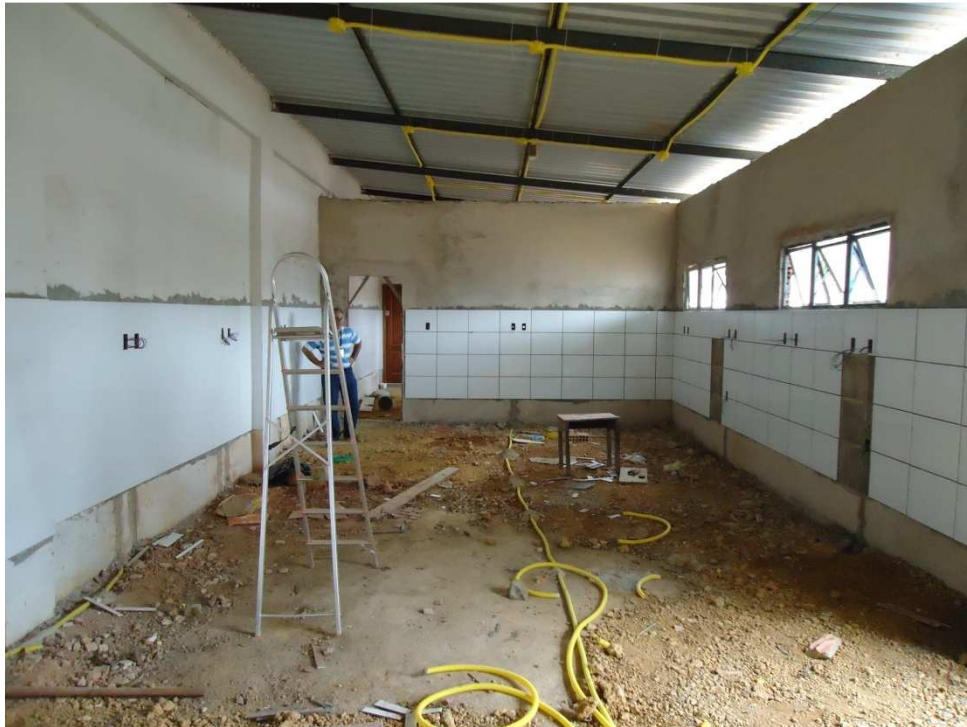
Figura 3.7. Construção do Novo Laboratório de Sedimentos
