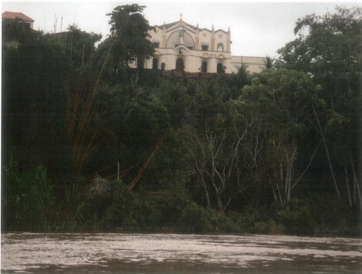
Foto 6 – Área edificada em cota elevada com talude estável. Na parte baixa, com vegetação, se depositam sedimentos recentes, onde ocorrem processos periódicos de deposição e erosão.
