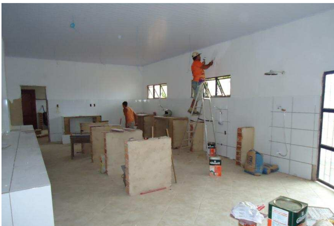
Figura 3.3. Instalações do Novo Laboratório de Hidrossedimentologia
