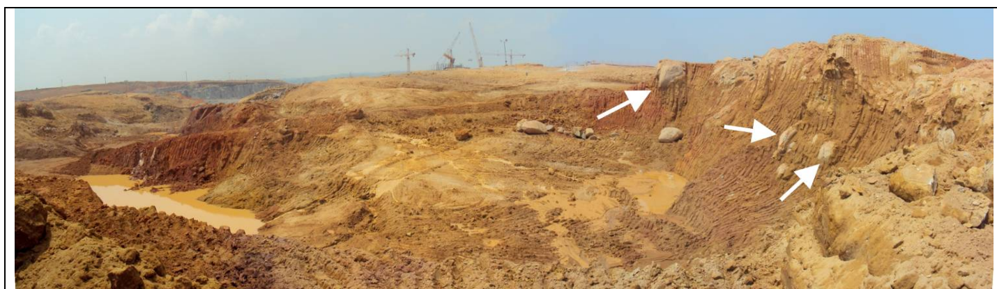
Figura 4. Vista panorâmica de parte da área escavada ao lado do vertedouro. As setas indicam alguns locais em que a escavação alcançou o topo rochoso.
