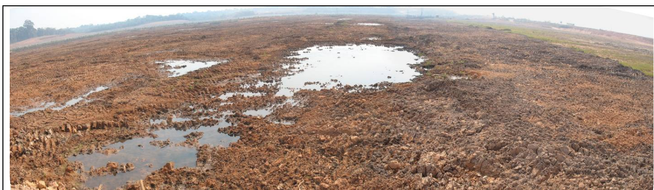
Figura 2. Vista panorâmica das escavações na área do Igapó.
