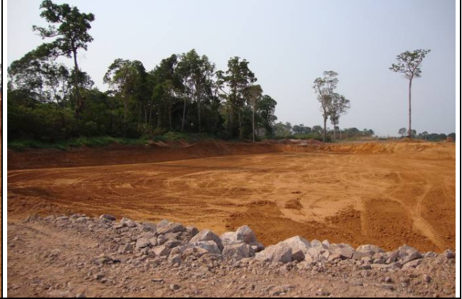
Fotos 2 e 3 – Ampliação das bacias de decantação na JT-7, nos lados direito e esquerdo do acesso AMD-07, sentido portaria Vila Princesa → pátio de montagem eletromecânica.
