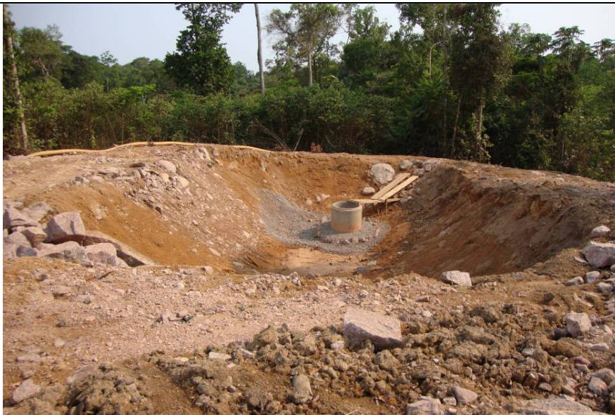
Foto 1 – Ampliação da bacia de decantação na JT-7, lado esquerdo do acesso AMD-07, sentido portaria Vila Princesa → pátio de montagem eletromecânica.
