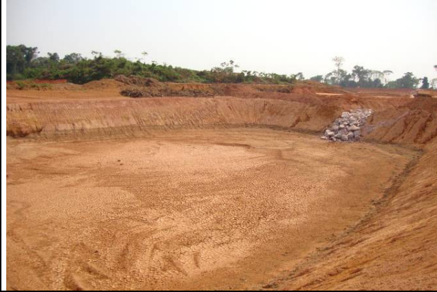
Fotos 2 e 3 – Ampliação das bacias de decantação na JT-7, nos lados direito e esquerdo do acesso AMD-07, sentido portaria Vila Princesa → pátio de montagem eletromecânica.
