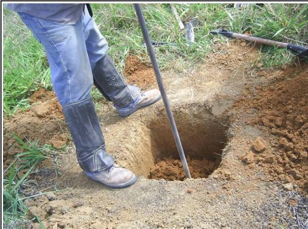
Foto 1 – Escavação para instalação dos estaios
