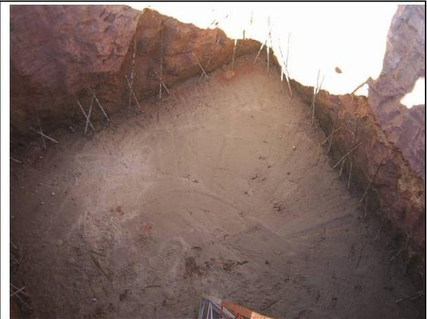
Foto 2 – Detalhe da escavação com inserção de cimento
