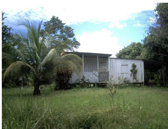
Casa fechada, proprietários ausentes
