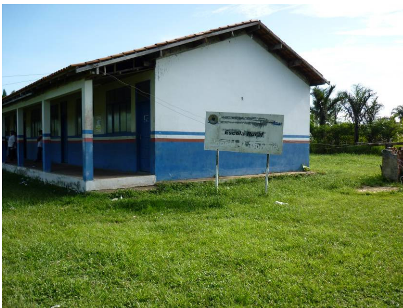
Prédio da Escola Municipal João de Barros Golveia
