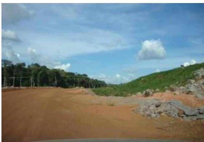
**FOTO 2.1. 2:** Implantação de enrocamento nos pontos de descidas da drenagem
