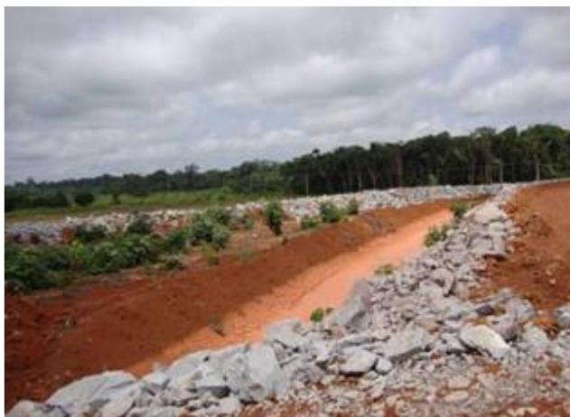
**FOTO 2.1. 3:** Implantação de enrocamento e abertura de valas de contenção de sedimentos
