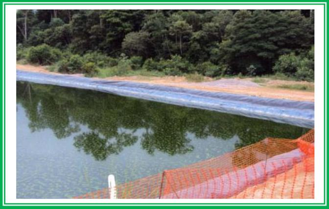
Impermeabilização da célula do aterro sanitário na Margem Direita.
