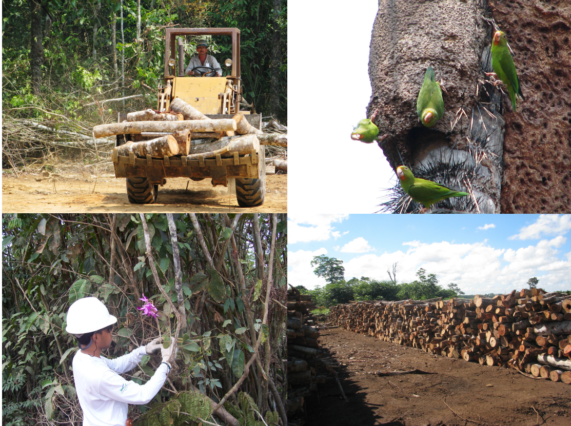
Canteiro de obras – Margem direita
