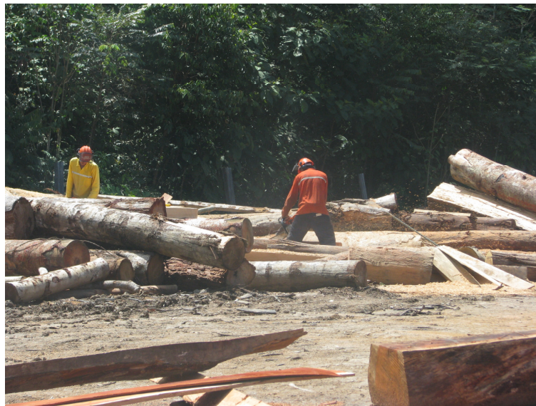
Foto 6 – Traçamento das toras para aproveitamento no canteiro de obras (E: 395 518 N: 9 025 663)
