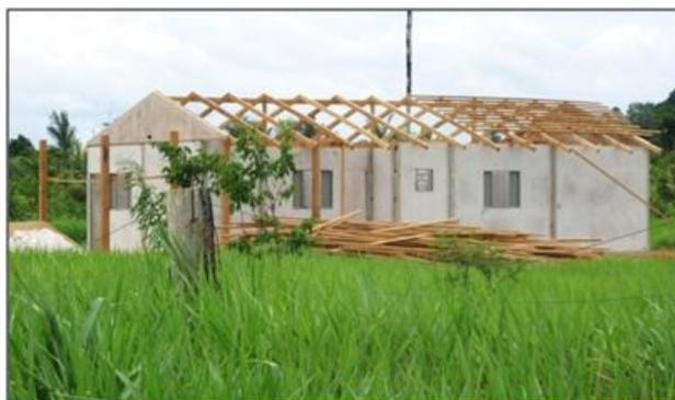
**FOTO 22. 10:** Detalhe da estrutura do telhado de casa em construção com 100 m<sup>2</sup>.
