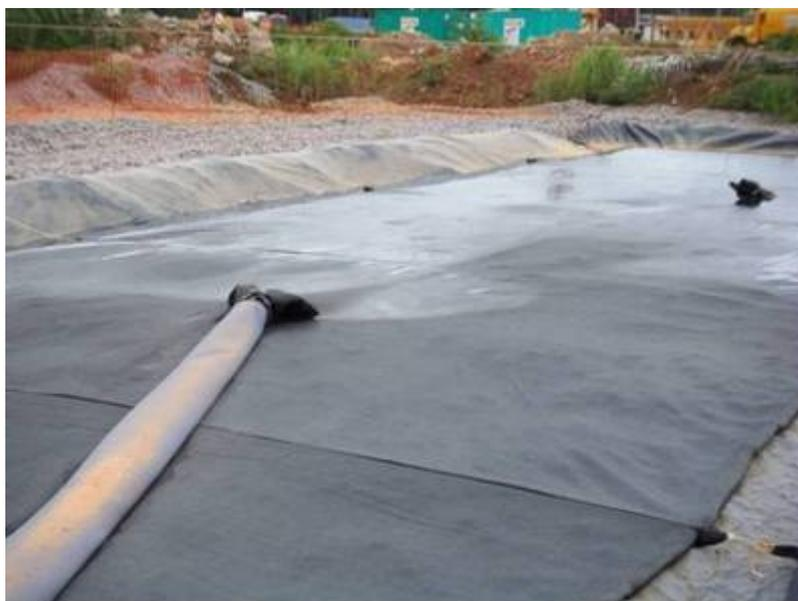
**FIGURA 2.1. 7:** Detalhe da água com coagulante entrando na geoforma.
