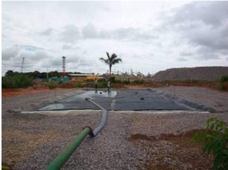
**FIGURA 2.1. 6:** Bacia de drenagem onde estão instaladas as duas geoformas que atualmente tratam o lodo da ETA 20m<sup>3</sup>/h de água potável da ME.
