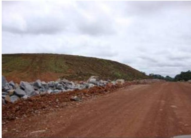
**FIGURA 2.1. 3:** Revegetação do talude do bota e execução de enrocamento para dissipação da energia da água
