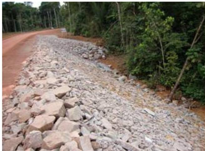
**FIGURA 2.1. 4:** Execução de enrocamento para proteção do talude do acesso
