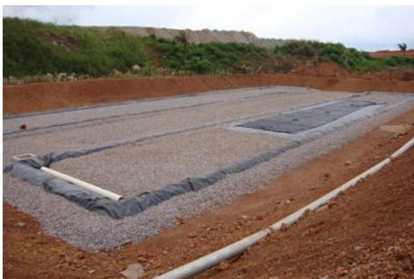
**FIGURA 2.1. 9:** Implantação da estrutura para o tratamento do lodo das ETAs industriais da ME.
