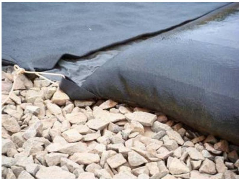
**FIGURA 2.1. 8:** Detalhe das geoformas instaladas para tratamento do lodo da ETA 20m<sup>3</sup>/h de água potável da ME: a geoforma do lado esquerdo está vazia diferentemente do lado direito.
