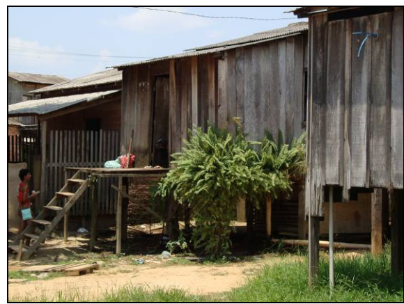
Casas edificadas sobre palafitas em área de inundação. Notar as tubulações hidráulicas que levam o esgoto doméstico ao nível do solo, por onde escorre aos igarapés mais próximos.
