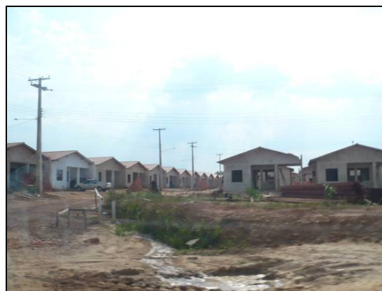
Vista de condomínio em fase de construção dentro dos limites da área
