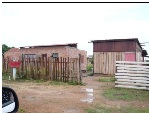
Tipologia comum à área do bairro Ayrtton Senna. Notar processo de substituição das edificações em madeira pelas de alvenaria.
