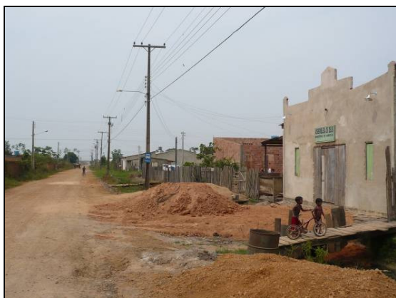
Vista geral da ocupação da área. Tipologia residencial unifamiliar predominante. A passarela de madeira é comumente utilizada para transpor as valetas formadas ao longo das vias e acessar as residências.
