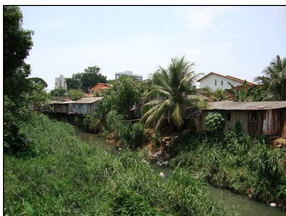
Vista de um dos conjuntos localizados às margens do córrego
