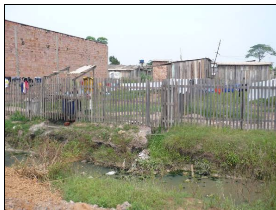
Separação regular dos lotes entre as famílias. Notar valetas entre a rua e as residências com deposição de esgoto
