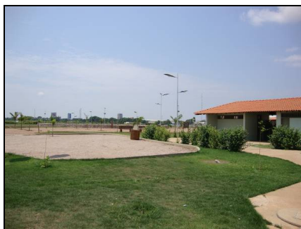
Vista das obras do Instituto Federal de Educação, Ciência e Tecnologia
