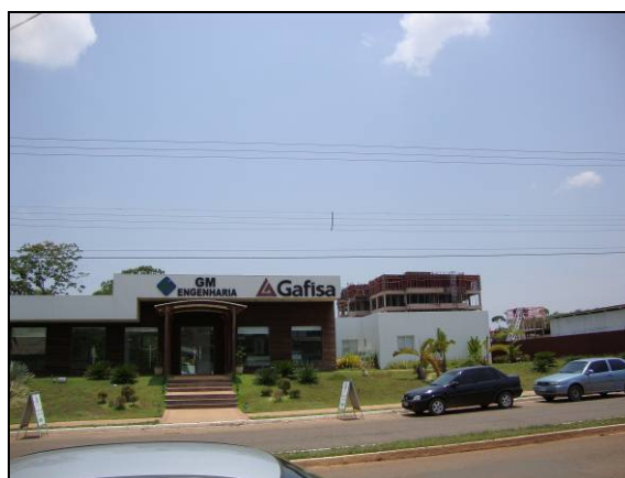
Vista, a partir da Av. Lauro Sodré, do empreendimento residencial vertical em construção.
