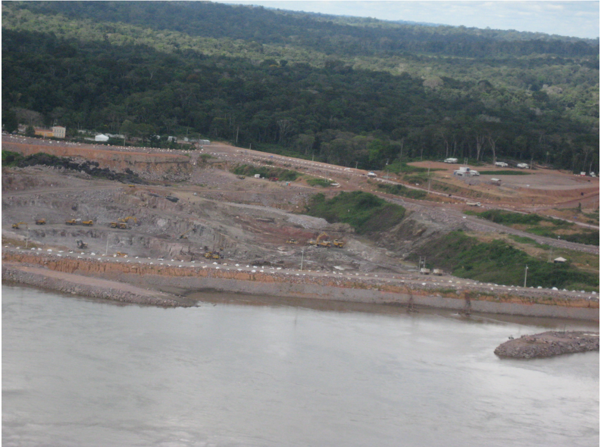
Canteiro de Obras, Margem direita – maio/2009
