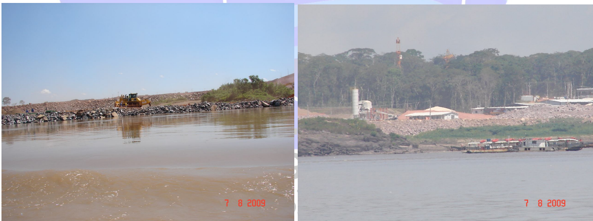
Figuras 14 e 15. Área do Canteiro de Obras onde foram amostrados os sedimentos do material escavado.
