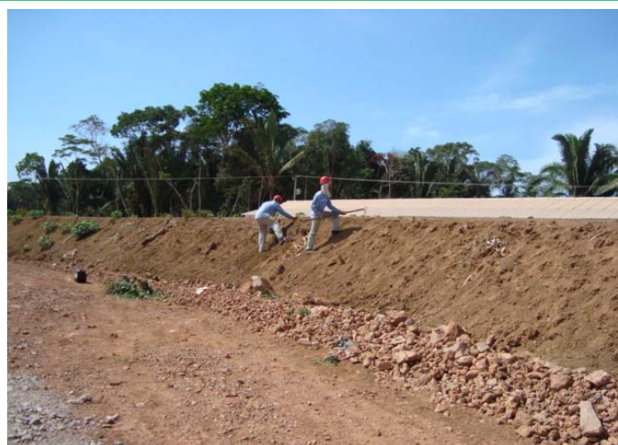
Recuperação do Dique divisor Ambulatório/Posto de Combustível - ME.
