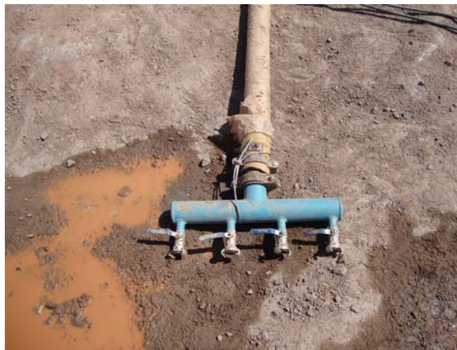
Dispositivo de segurança em cabeçote de ar.
