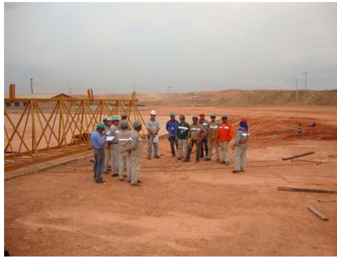
Aplicação de APT Montagem de GRUA.
