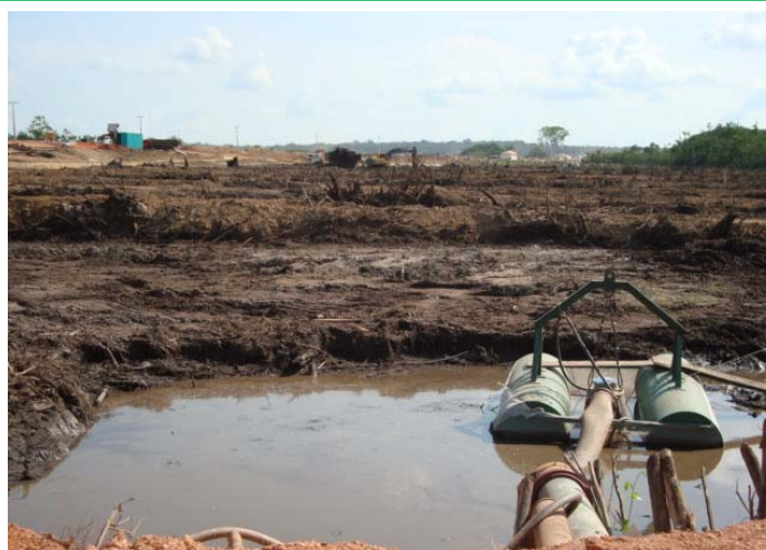
Poço escavado para o bombeamento da água drenada do Igapó.
