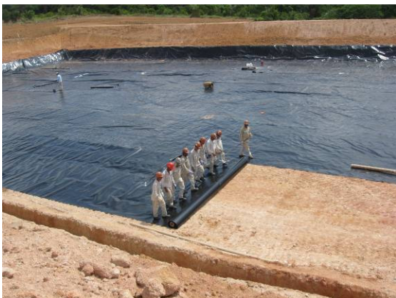
Estação de Tratamento de Esgoto – ETE/ Serviço de impermeabilização da lagoa.
