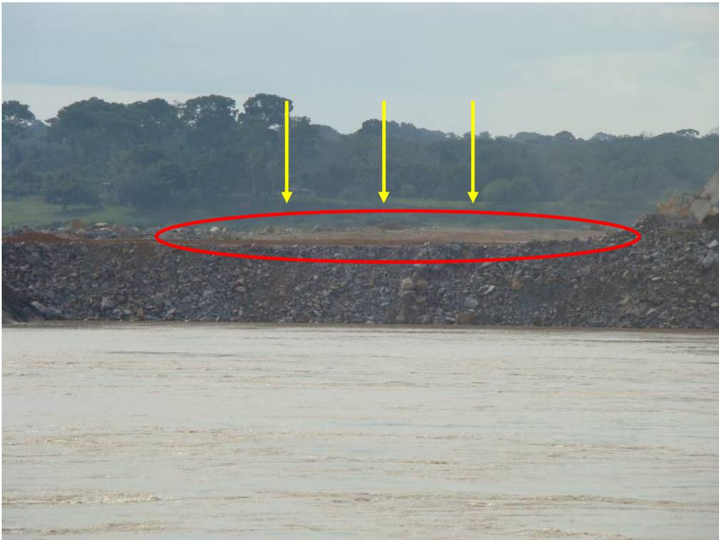
**Foto 3** Ensecadeira LR 1 completamente aterrada em 22/10/2009 (setas e detalhe).
