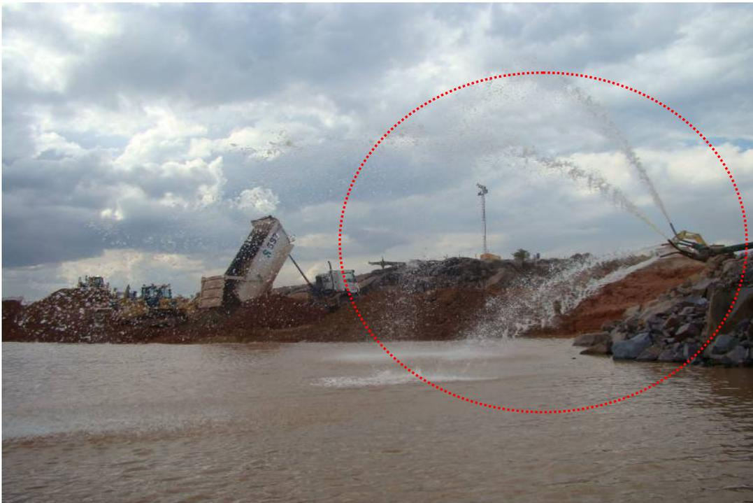
**Foto 2.** Aerador e renovador de água instalado no interior da ensecadeira LR1 para melhoria dos níveis de oxigênio dissolvido (detalhe).
