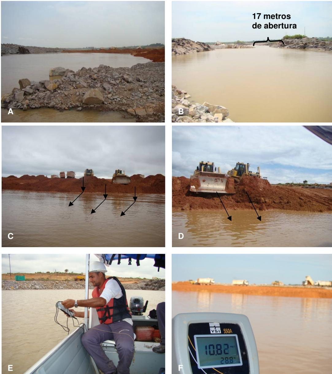
**Prancha 6.** Detalhes da atividade de aterramento da enseadeira LR1: (A) lançamento do eixo de montante; (B) lançamento do eixo de jusante com abertura de 17 metros (detalhe); (C e D) aterramento da enseadeira de cima para baixo com utilização de tratores que empurravam a terra de forma com que ela ocupasse os espaços sem soterrar os peixes (setas) e (E e F) monitoramento diário de temperatura e oxigênio na área no interior da enseadeira LR1.
