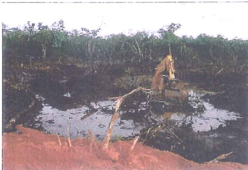
Foto 5: Detalhe de máquina de esteira atolada durante as atividades de desmatamento.
