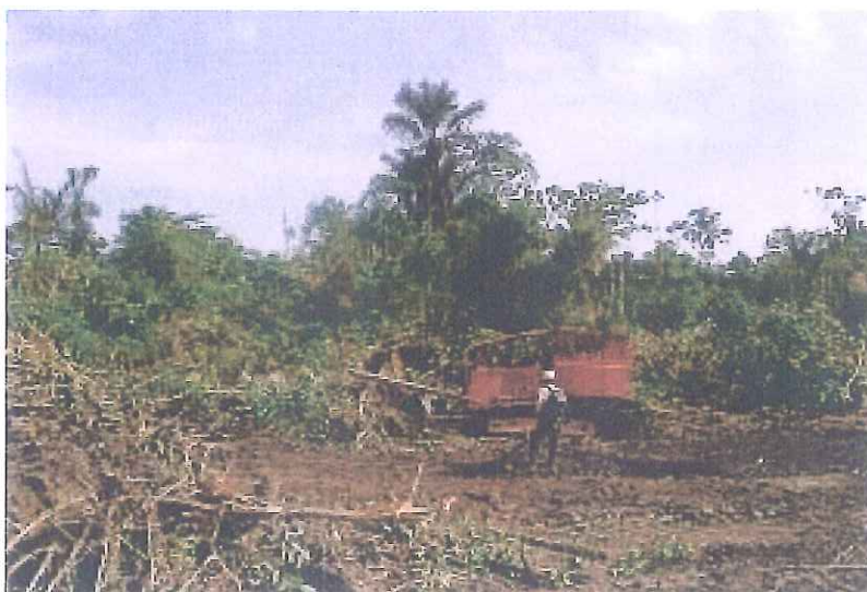
Foto 2: Início das atividades de desmatamentos, detalhe para trator de esteira, parte do material lenhoso disposto em forma de leira e técnico acompanhando as atividades de desmate..
