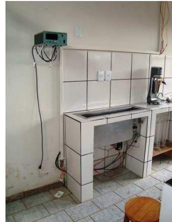
Instalação do tanque de pipetagem
