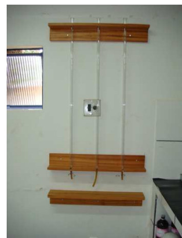
Tubos de remoção pela base instalados
