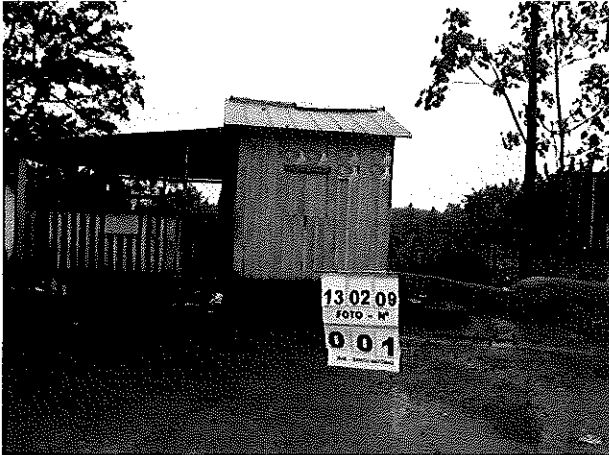
Foto - Vista da Residência
