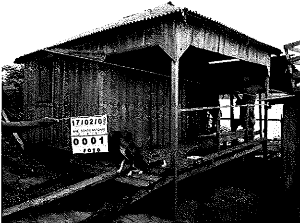
Foto - Vista da Moradia
