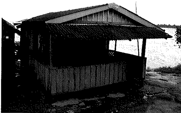
Foto - Vista da Residência
