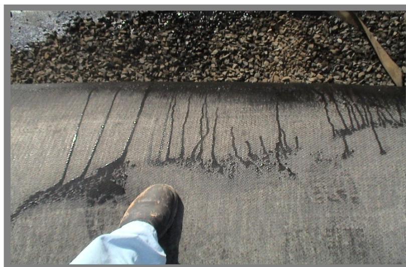
Figura 03 – Processo de drenagem da água pelos poros do tecido
