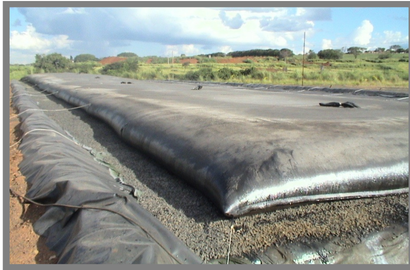
Figura 01 – Vista do Geotubo em processo de enchimento.
