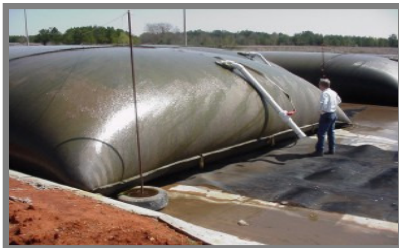
Figura 04 – Vista do Geotubo em final de ciclo.
