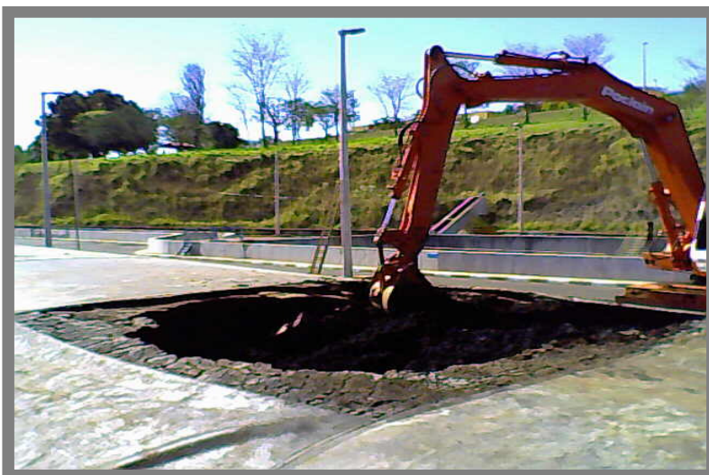
Figura 05 – Detalhe da remoção do lodo desidratado
