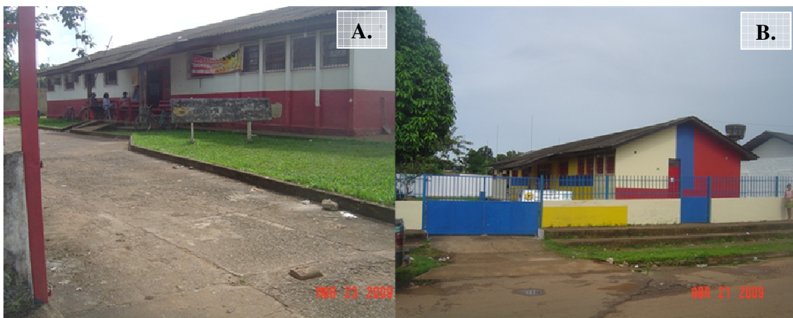
FIGURA 19 - 9 – A: Centro de Saúde Caladinho antes do processo de revitalização executado pela Santo Antônio Energia. B: o mesmo Centro de Saúde após a reforma.
