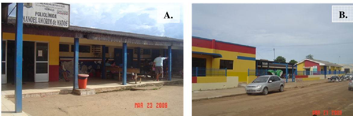
FIGURA 19 - 10 – A: Policlínica Manoel Amorim de Matos antes do processo de executado pela Santo Antônio Energia. B: a mesma Policlínica após a reforma.
