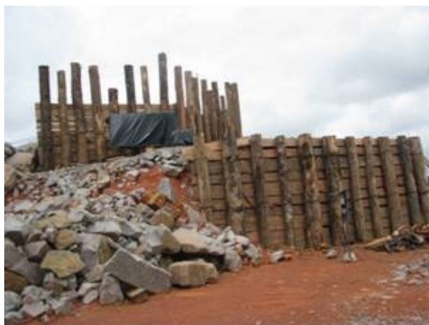
FOTO 13 - 6 – Utilização da madeira na obra.
