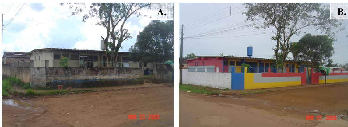
FIGURA 19 - 3 – A: Centro de Saúde Renato Medeiros antes do processo de revitalização executado pela Santo Antônio Energia. B: o mesmo Centro de Saúde após a reforma.
