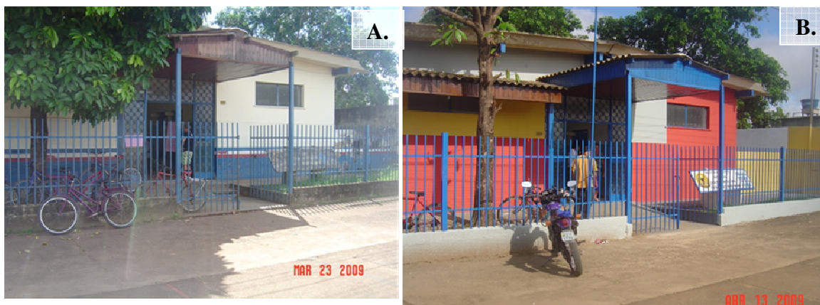
FIGURA 19 - 6 – A: Centro de Saúde Maurício Bustani antes do processo de revitalização executado pela Santo Antônio Energia. B: o mesmo Centro de Saúde após a reforma.
