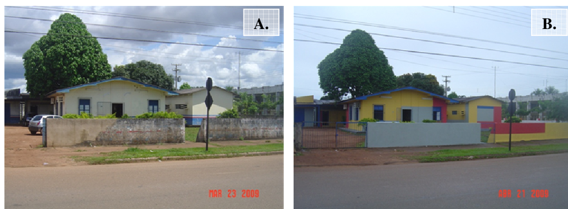
FIGURA 19 - 4 – A: Centro de Saúde Pedacinho de Chão antes do processo de revitalização executado pela Santo Antônio Energia. B: o mesmo Centro de Saúde após a reforma.
