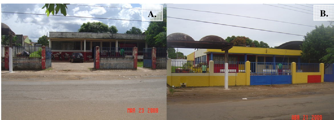
FIGURA 19 - 11 – A: Centro de Saúde Osvaldo Piana antes do processo de revitalização executado pela Santo Antônio Energia. B: o mesmo Centro de Saúde após a reforma.
