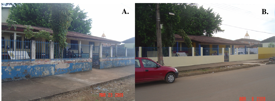
FIGURA 19 - 8 – A: Centro de Saúde Agenor de Carvalho antes do processo de revitalização executado pela Santo Antônio Energia. B: o mesmo Centro de Saúde após a reforma.
