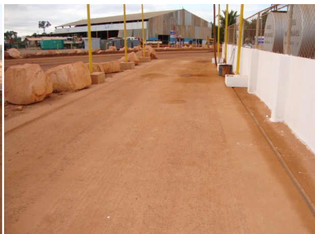
FOTO 3 – Posto de abastecimento ME – sistema de canaletas na área de descarga do combustível
