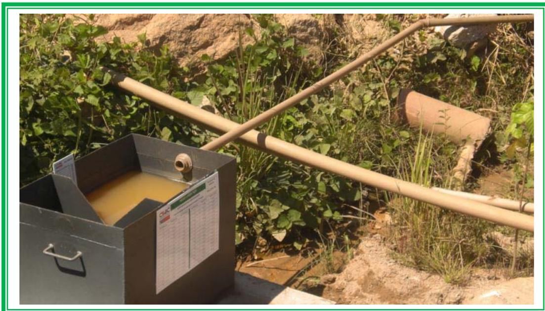
Melhorias no sistema de reuso de água do tanque de decantação do lavador de betoneira e drenagem da central de concreto.
