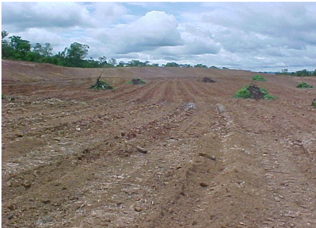
Quadro nº 20 – Abertura de sulcos em nível, mostrando as linhas em nível com espaçamento determinado de acordo com o distanciamento proposto (Foto ilustrativa - UHE-Cana Brava, 2001)
