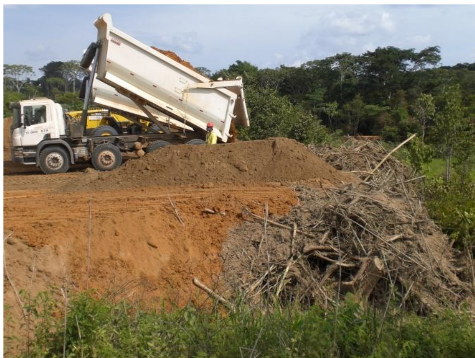
Quadro nº 11 – Disposição do material orgânico gerado no processo de supressão vegetal nas pilhas de solo vegetal
