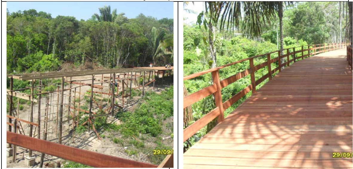
Construção do píer para acesso à escola, à praia e à pesca.
