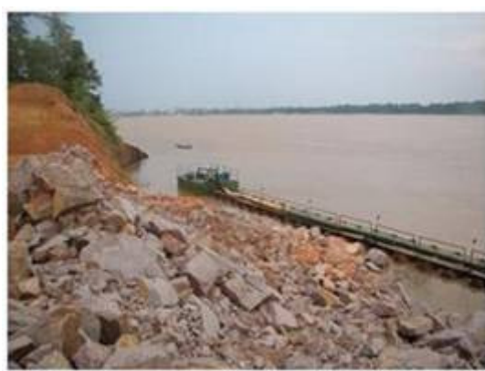
FOTO 2: Instalação a jusante aproveitando o píer da bomba para alimentação de água do canteiro de obras na margem esquerda
