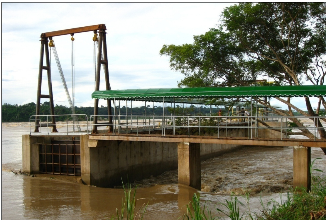
FIGURA 115: Aspecto do CET durante a cheia 2010. Ressalta-se que os experimentos só são efetivos e possíveis com vazões acima de 22.00 m 3 /s, que ocorrem em geral de janeiro a maio no rio Madeira
