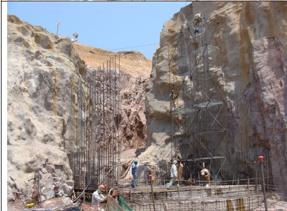
Evidência dos trabalhos de escavação e concretagem no local do portal direito do STP localizado na ilha do presídio
