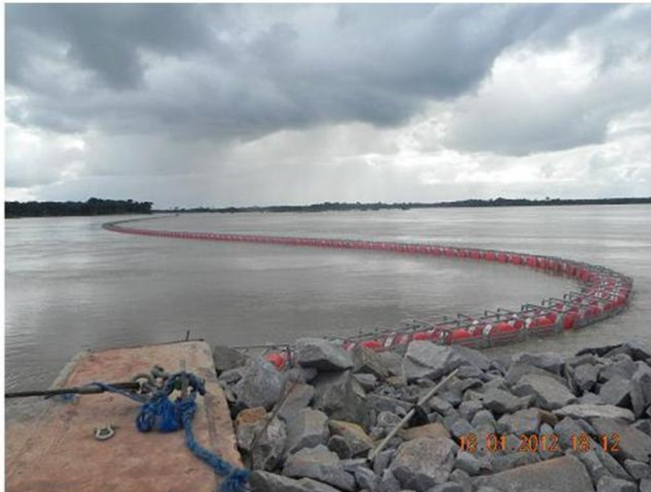
Figura 26 – Log-boom de proteção – Casa de Força 1 – Blocos 5-4.
