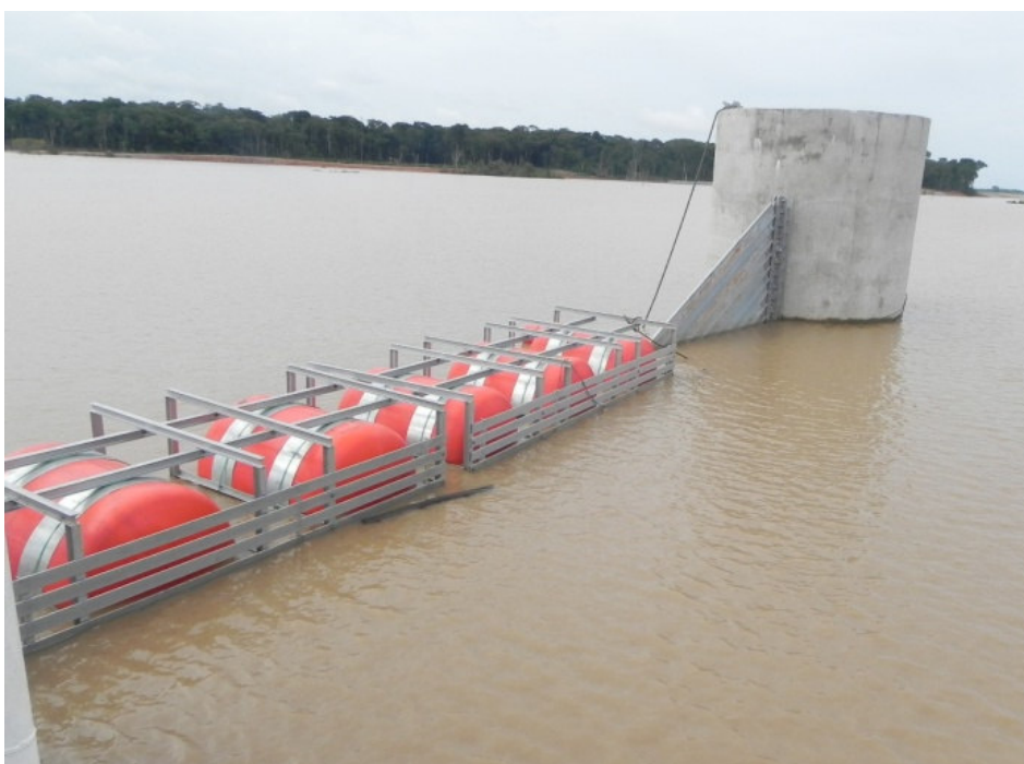
Figura 24 – Log-boom definitivo em fase de instalação.
