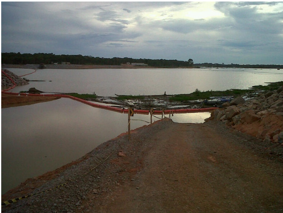
Figura 27 – Log-boom provisório, instalado para proteção da CF1 e Canal de Saída de Peixes enquanto é montado o logboom definitivo
