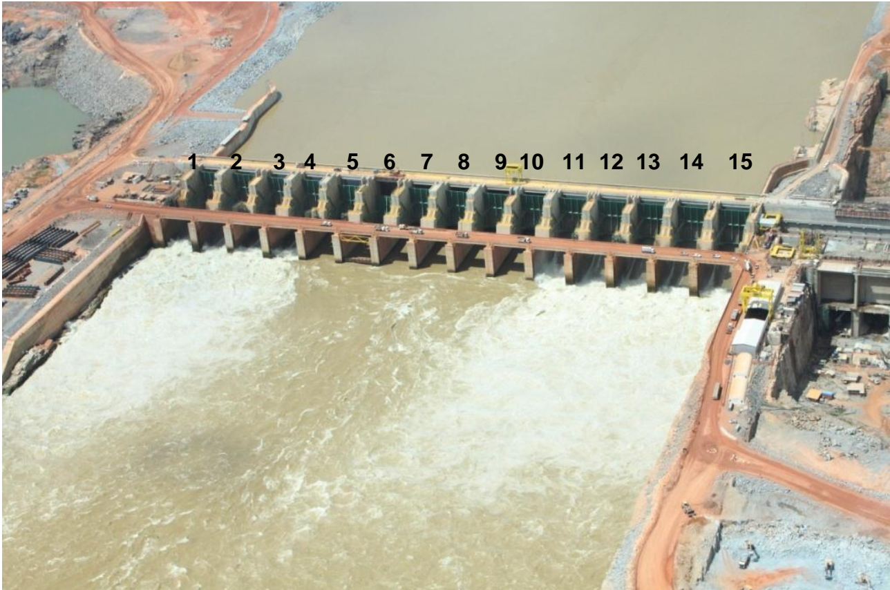
Foto 1 – Detalhe dos vãos do vertedouro principal onde serão realizadas atividades de resgate de ictiofauna para construção das ogivas – UHE Santo Antônio, rio Madeira/RO.
