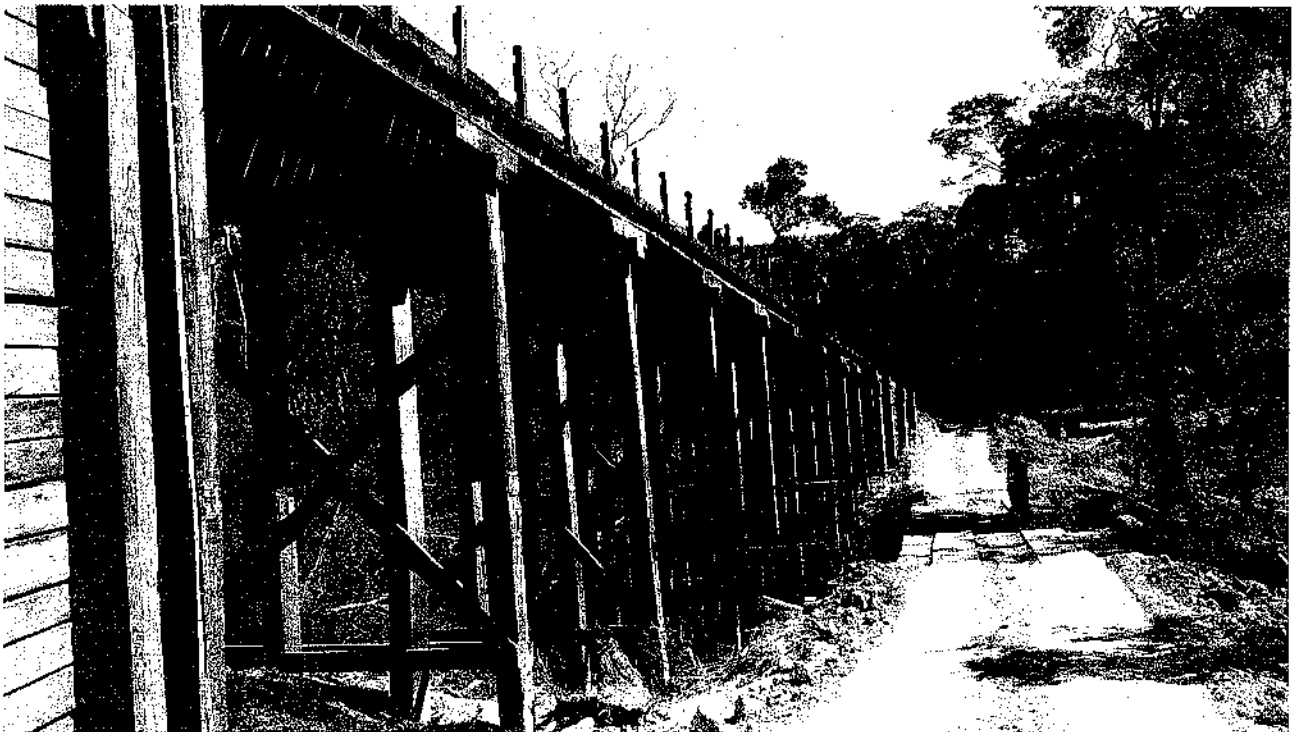
Foto 4: Dimensão da ponte sobre o rio Castanho.
