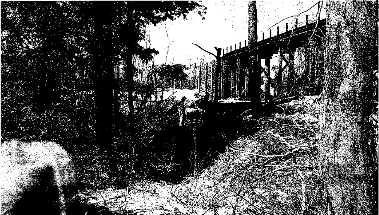
Foto 8: Construção da ponte sobre o rio Castanho.
