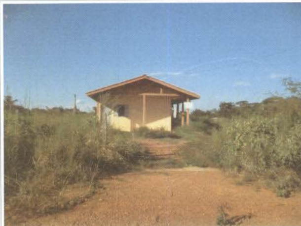
Foto 03. Moradia com aspecto de abandono - Vila Nova Teotônio.
