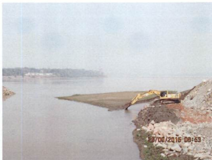
Imagem 2: Manutenção preventiva da tomada d'água do STP, montante da UHE Santo Antônio
