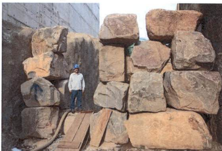
Figura 2 – Defletor de matacos no canal lateral esquerdo,
