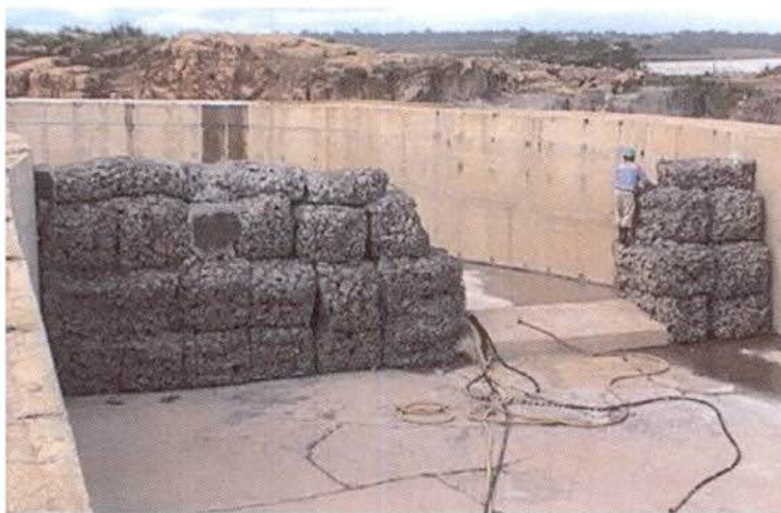
Figura 1 – Defletor do Canal Principal em Gabiões
