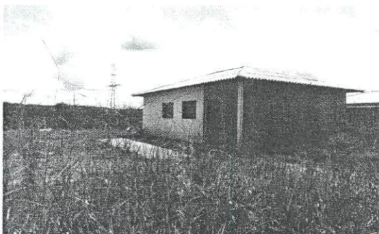
Casa abandonada em Nova Mutum Foto João Marcos Dutra, 2013
