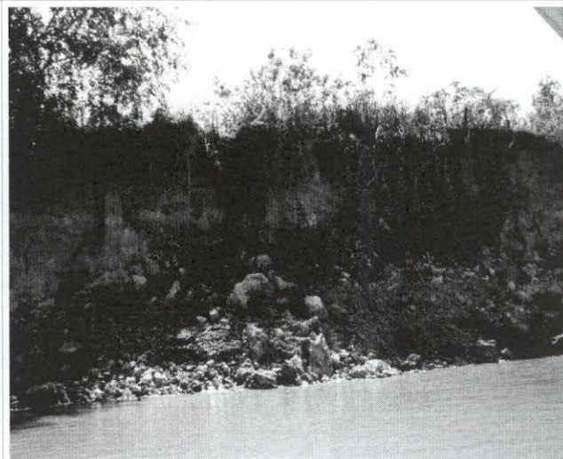
Foto 13. Desbarrancamento natural do rio Madeira
