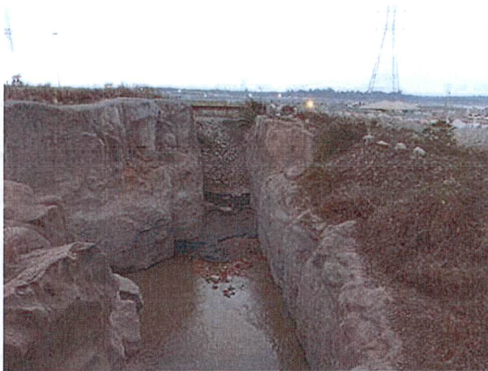
Foto 1 – Enseadeira no encontro do segundo braço do STP com o primeiro braço em operação - Vista a montante
