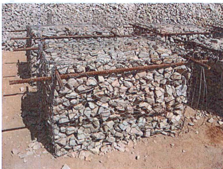
Figura 1. Gabião finalizado no canteiro de montagem.
