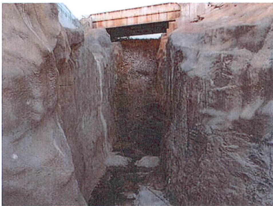
Foto 2 – Enseadeira no encontro do segundo braço do STP com o primeiro braço em operação - Vista a jusante
