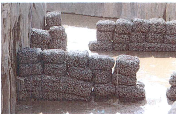
Figura 2. Vãos entre os gabões em defletores do Sistema de Transposição de Peixes da UHE Santo Antônio.
