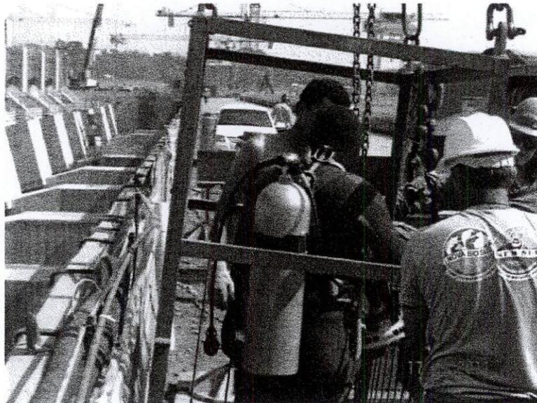
Figura 6 - Mergulhador retorna de verificação dos *stop logs* no vão 5, antes que seja liberada a ensecagem do recinto.
