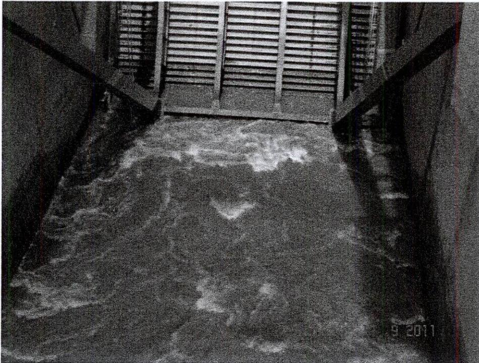
Figura 8 - Vista de jusante da comporta do vão 6 com a bandeja coberta com um filme d'água onde peixes ficaram retidos após saltarem e acabaram perecendo por asfixia e/ou dessecação. É possível observar forte turbulência a jusante provocada pelo fato de que a base da comporta está parcialmente imersa.
