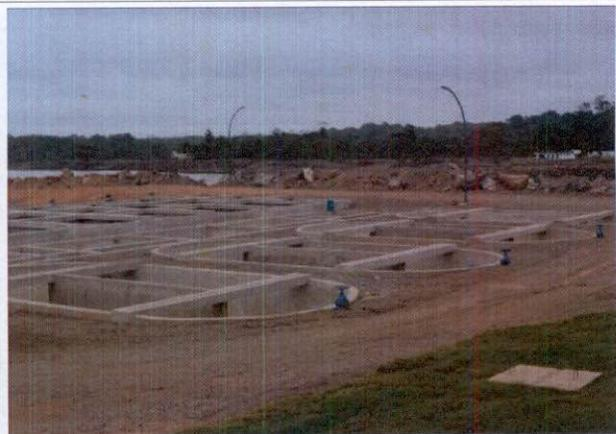
Foto 30. Tanques ovais em concreto (raceways)
