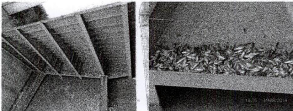
Figura 1 - Comporta 18 do Vertedouro Complementar em vista de jusante mostrando a "gaveta" onde peixes ficaram retidos após saltarem e acabaram perecendo por asfíxia e/ou dessecação.
