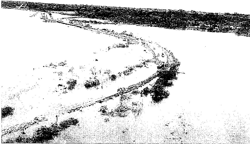
Trecho inundado da rodovia BR-364, entre o Km-798+0,00 e 800+860,00, nas proximidades da cidade de Jaci-Paraná
