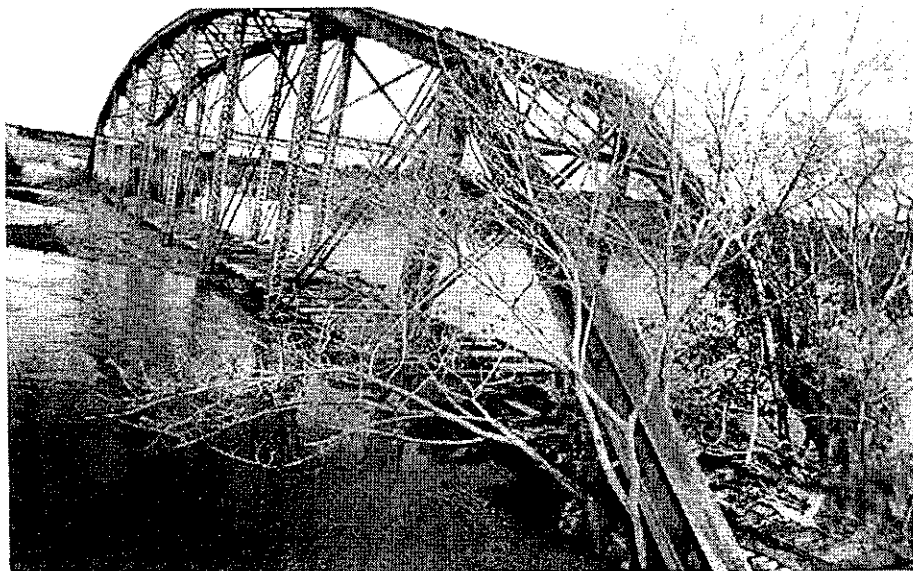
Ponte da EFMM sobre o Rio Jaci Paraná quando da operação da UHE Santo Antonio na cota 70,7m com uma vazão de 35.000 m 3 /s, a poucos centímetros de submergir.
