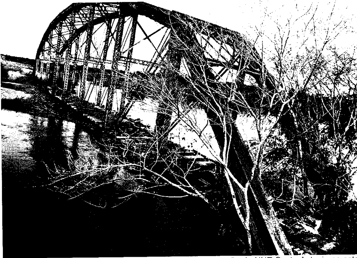
Ponte da EFMM sobre o Rio Jaci Paraná quando da operação da UHE Santo Antonio na cota 70,7m com uma vazão de 35.000 m 3 /s, a poucos centímetros de submergir.
