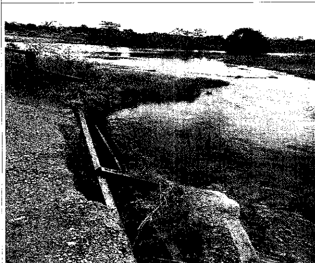
Foto 1. Rompimento de barragem na estrada no Reassentamento Santa Rita
