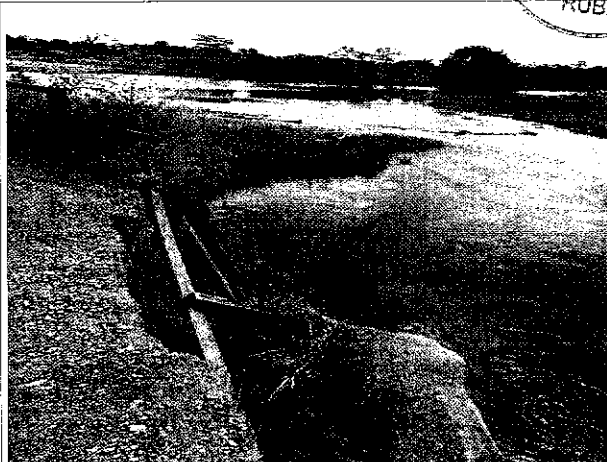
Foto 2. Rompimento de barragem na estrada no Reassentamento Santa Rita
