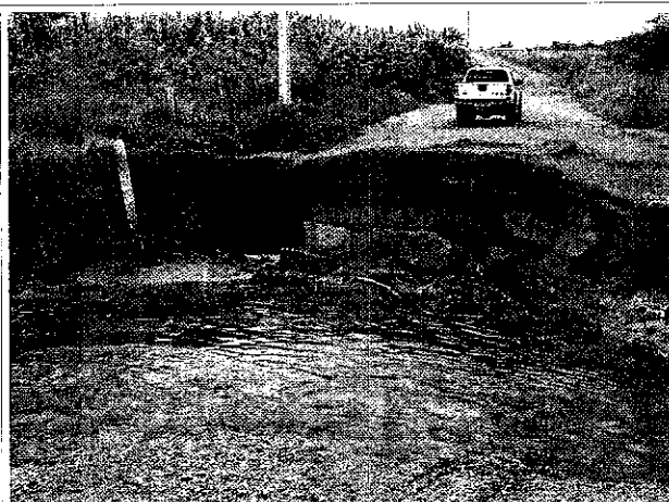
Foto 1. Rompimento de barragem na estrada no Reassentamento Santa Rita
