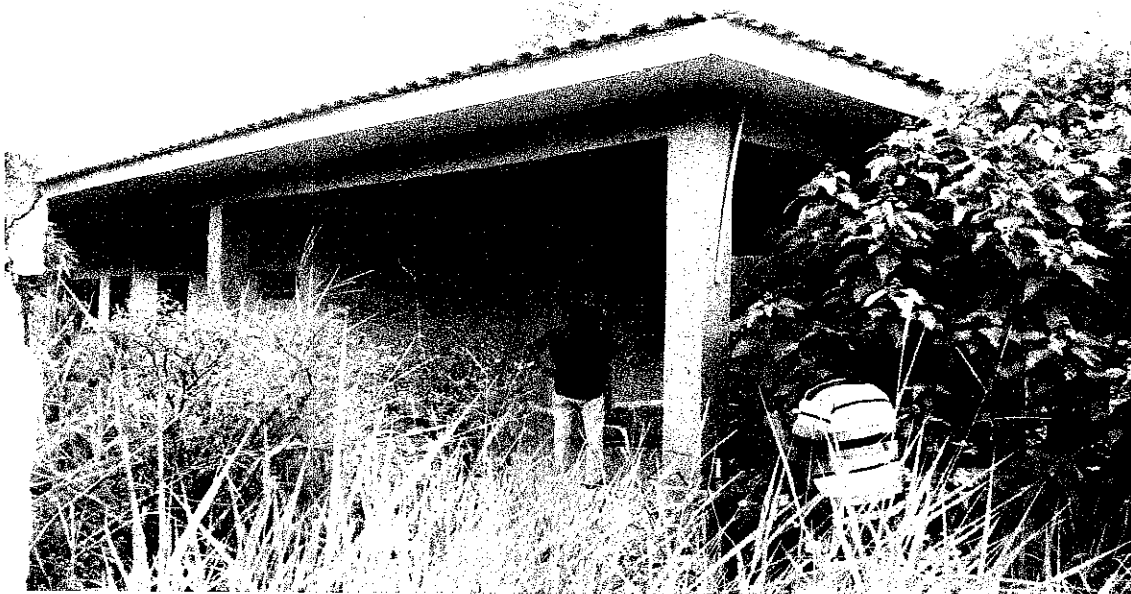
Foto 2 – Escola abandonada na Linha 17.
