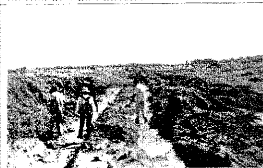
Foto 5: Compactação precária na Ilha do São Patrício.
