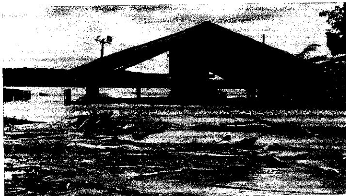
Foto 2 – Situação do atracadouro da margem esquerda,
