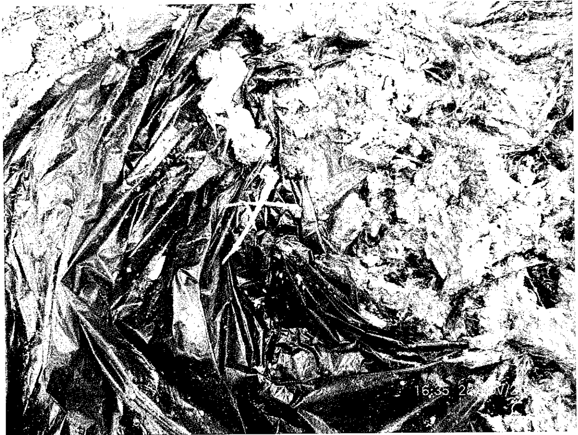
Material recolhido no canal de fuga da UG-20 durante a atividade de limpeza da sucção da UG-20. Aproximadamente 2kg.
