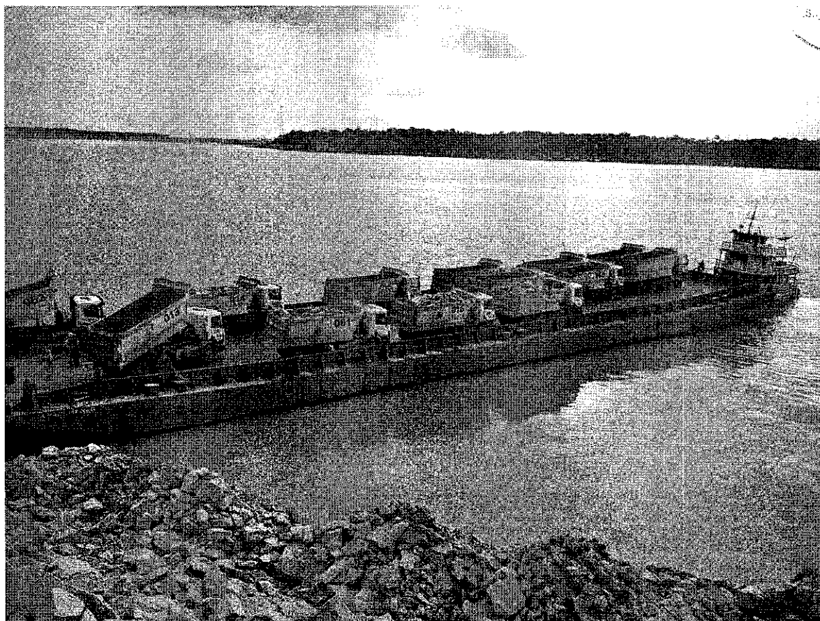
Foto 07 – Balça com caminhões basculantes descarregando rochas para construção da berma.
