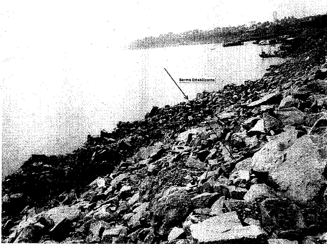
Foto 4-6 – Vista Superior da Berna Estabilizante -- 31/08/2012.
