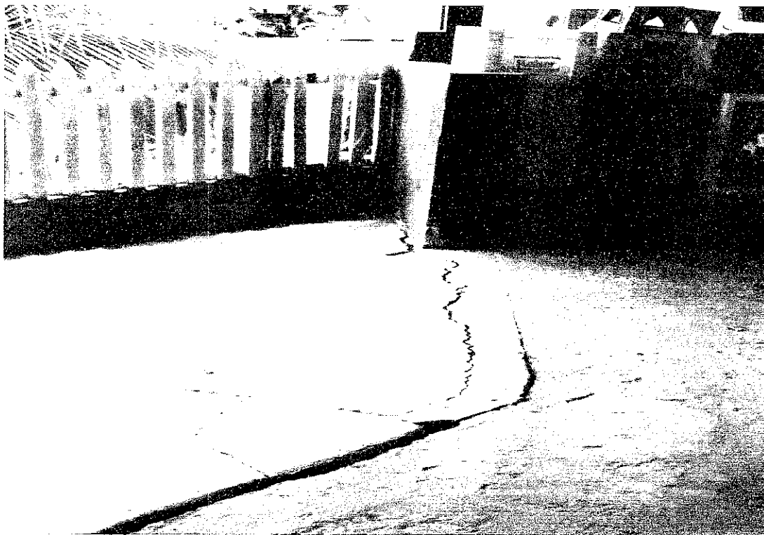
Foto 6: Rachaduras surgidas no restaurante Mirante III
