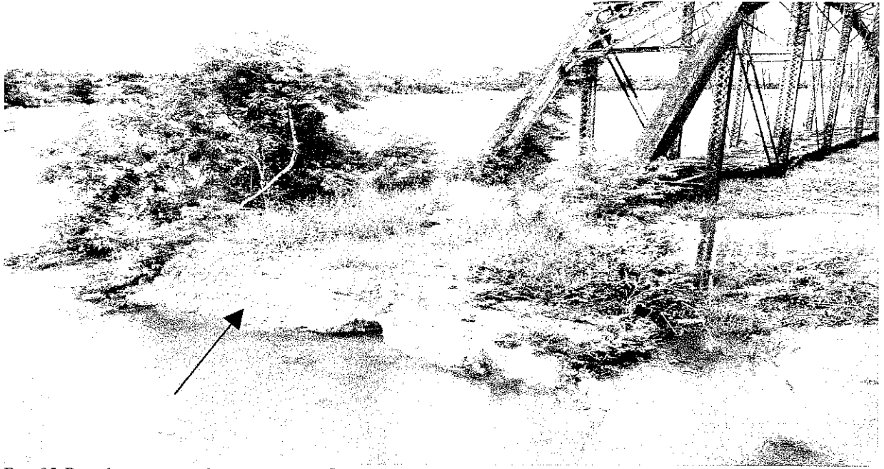
Foto 05. Base de ancoragem da ponte em terra firme, cortada para abertura de canal de navegação.
