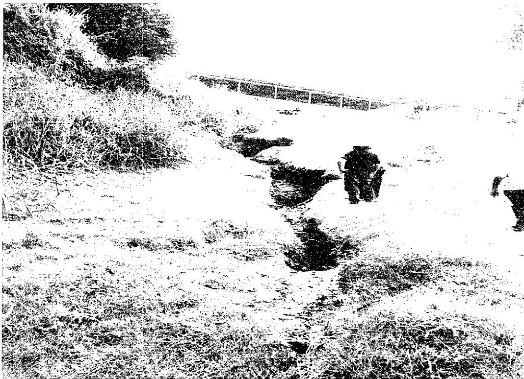
Foto 4: Voçoroca originada no talude localizado na Praça Madeira-Mamoré.
