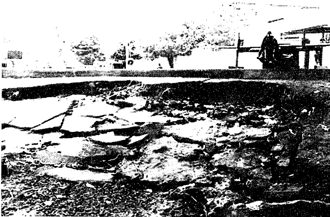
Foto 29: Estruturas afetadas na área do Porto Hidroviário (Cai n'Água)
