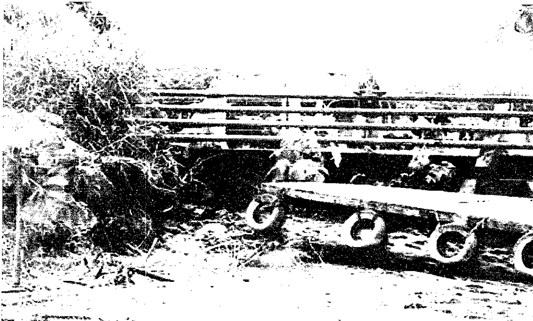
Foto 26: Desbarrancamento na praça Madeira Mamoré (Estação Ferroviária ao fundo)
