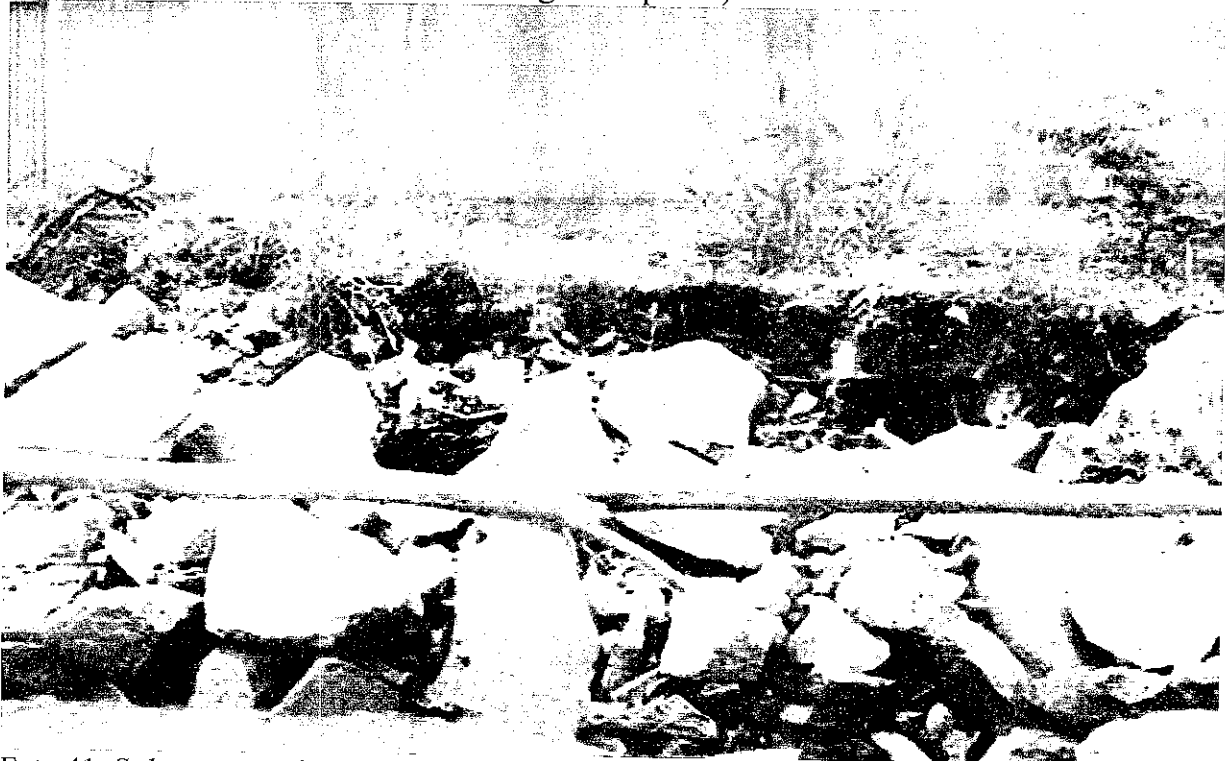
Foto 41: Solapamento do enrocamento próximo à Vila Candelária – Margem Direita
