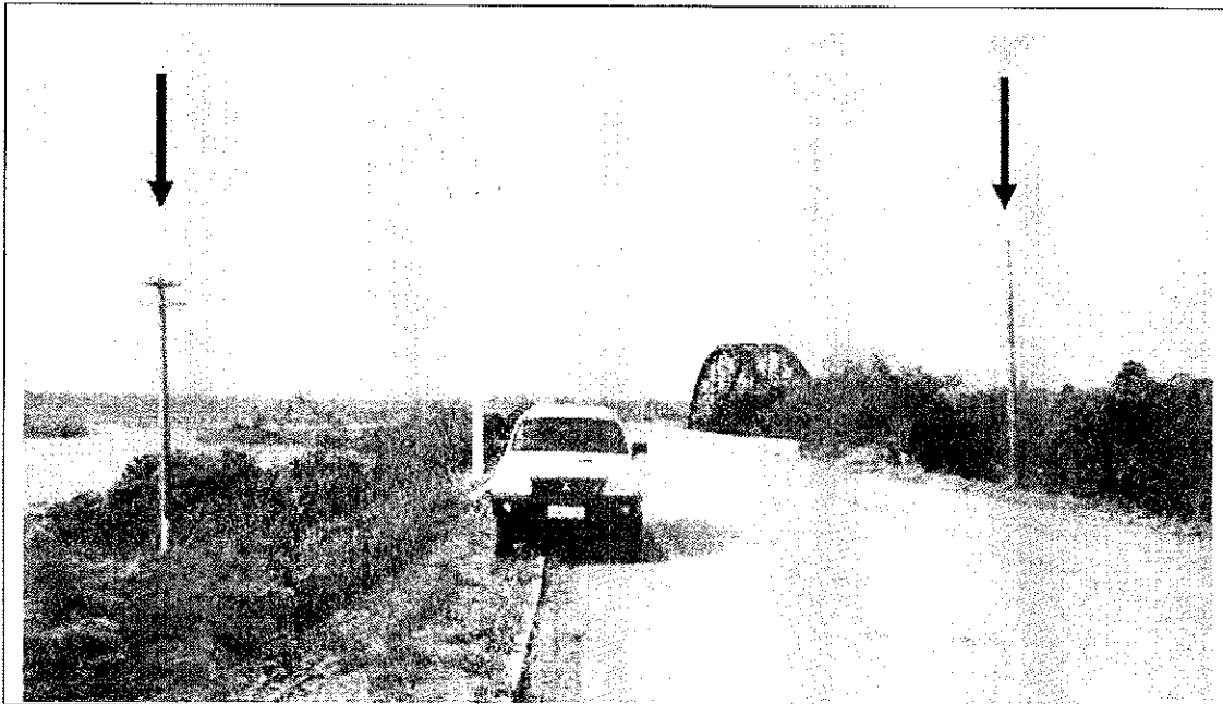
FOTO 02 – ANTES – 02 Postes de concreto desativados em terra próximos a ponte de Jacy-Paraná.
