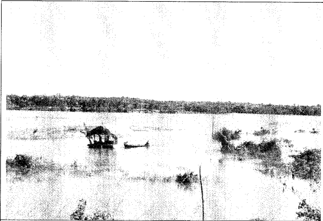
FOTO 05 – DURANTE - Execução da retirada dos postes de dentro da área inundada.
