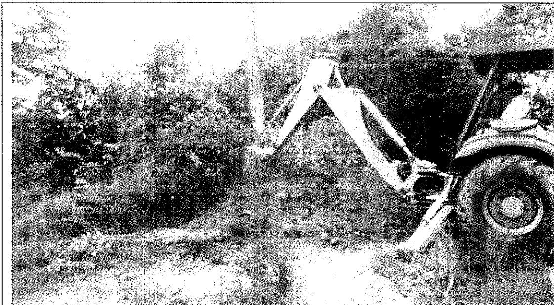
FOTO 08 – DURANTE - Escavação na lateral da fundação do poste.
