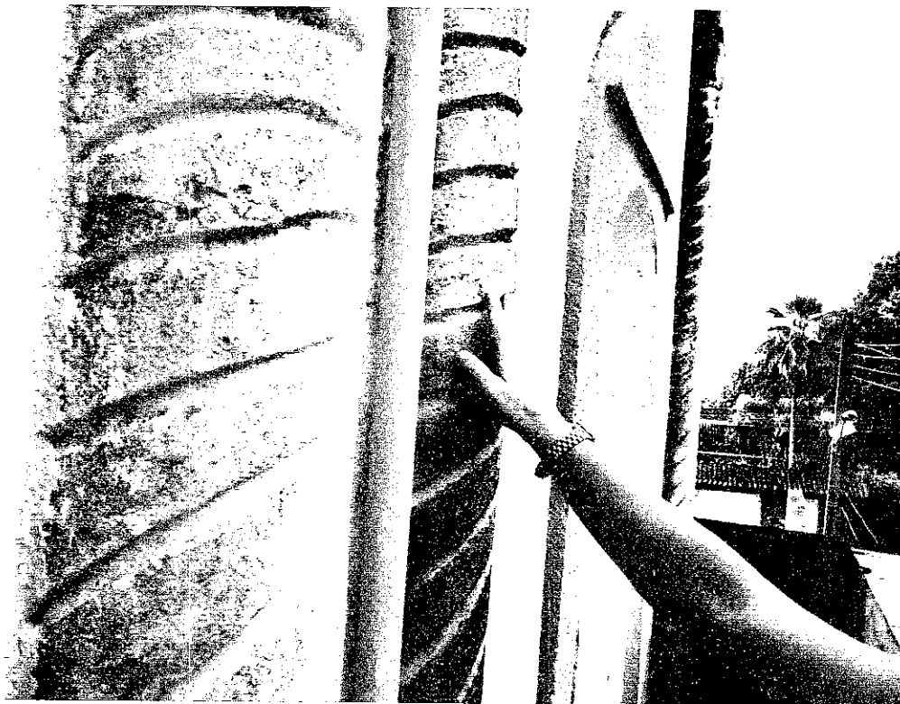
Foto 22: Parede e pilares apresentando rachaduras transversais.
