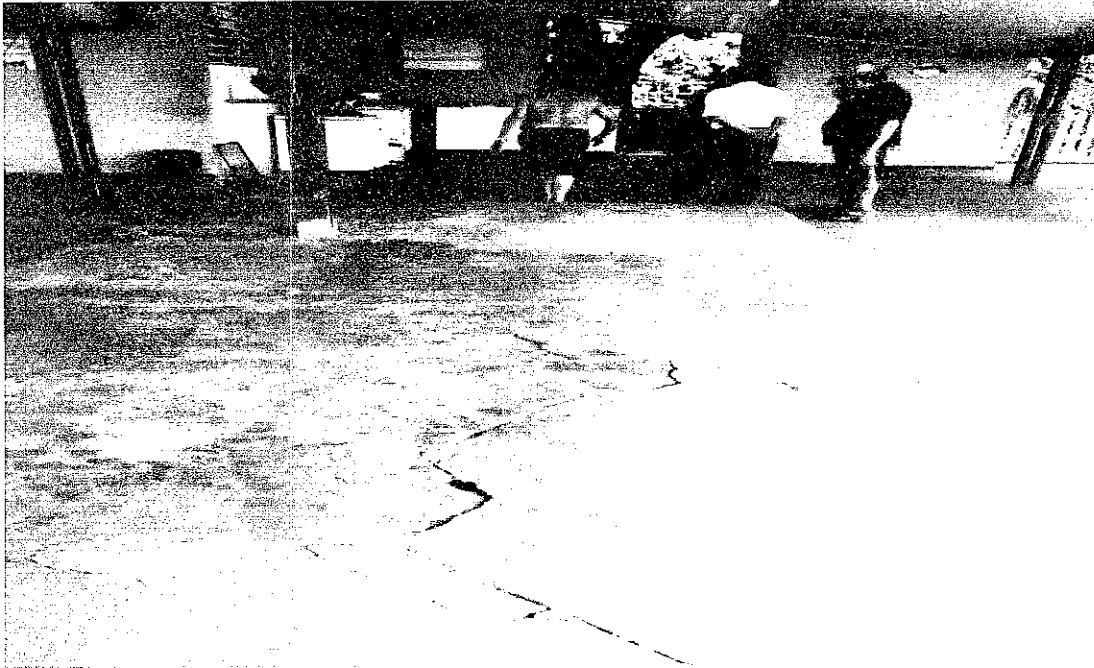
Foto 7: Rachaduras surgidas no Restaurante Mirante III
