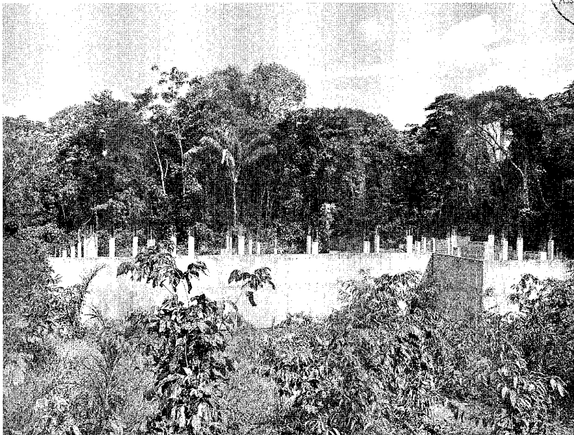
Foto 13 – Fundações Laboratório de Paleontologia
