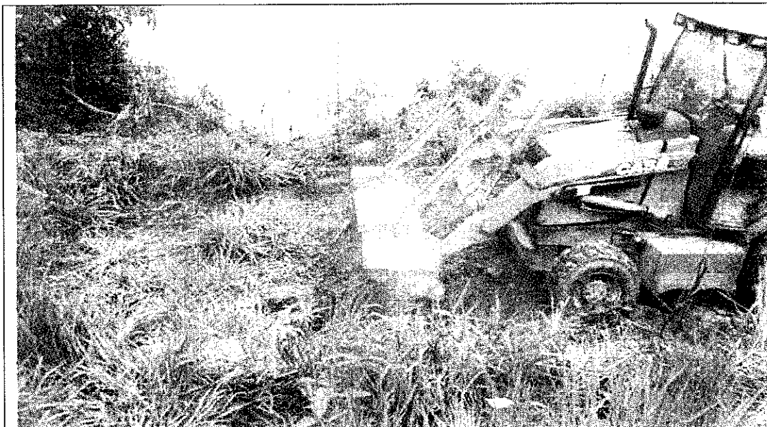
FOTO 11 – FINALIZAÇÃO - Reaterro do local aberto
