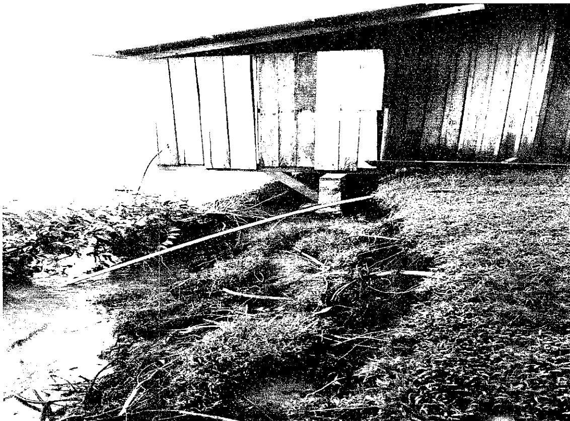
Foto 33: Solapamento do barranco sob estabelecimento comercial – Com. São Sebastião
