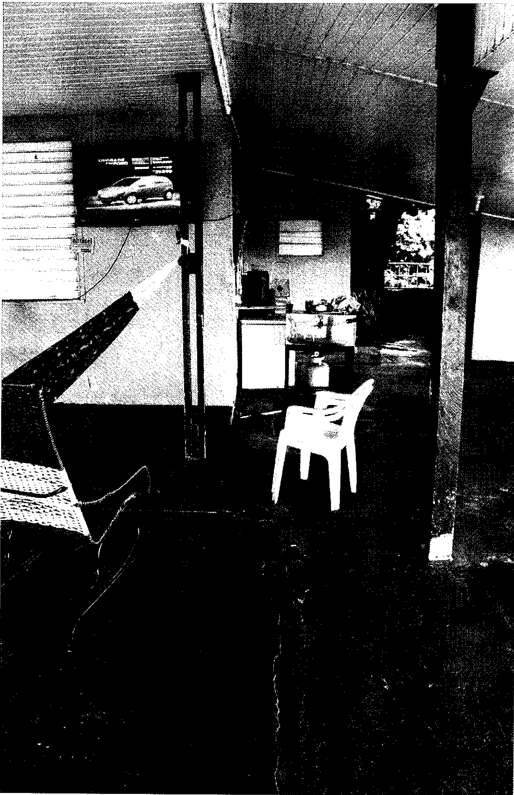
Foto 10 – Trincas no Mirante III.
