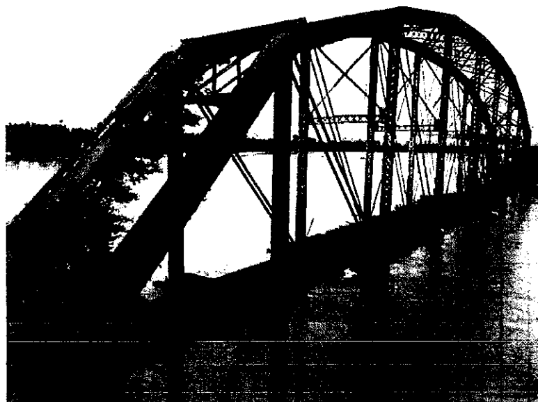
Foto 02 – Base na ponte ferroviária da EFMM, inundada pelo reservatório da UHE Santo Antônio, em 26 de março de 2013.
