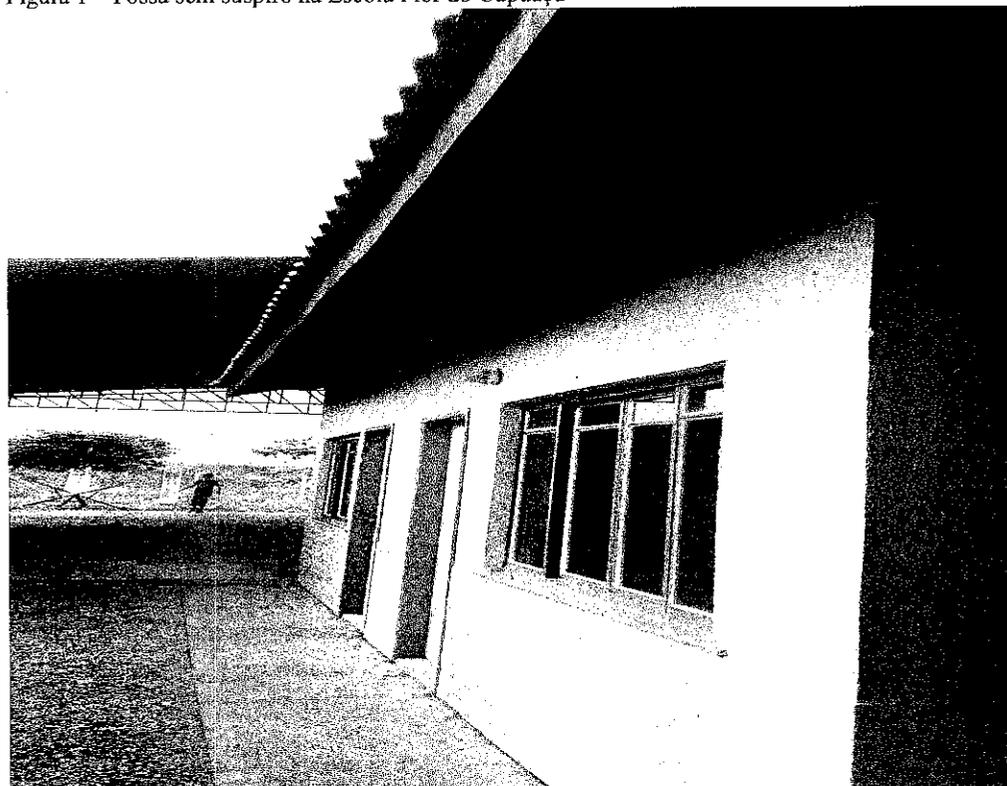
Figura 2 – Ausência de calhas e inadequação do piso quadra e do playground.
